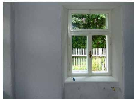
Izolace a sanace vlhkého zdiva omítkou Manto Plate® (1 cm). Stav stěn před a po aplikaci.
