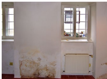
Izolace a sanace vlhkého zdiva omítkou Manto Plate® (1 cm). Stav stěn před a po aplikaci.
